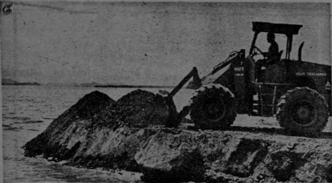
NUEVO ATRACADERO. — Vista general del proyecto que realiza la Dirección General de Obras Portuarias del MOPT, en el atracadero de Manzanillo, Puntarenas, para embarcaciones de poco calado y de transporte de productos del mar y agrícolas.
